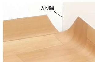
床材を壁に沿わせたら、幅広のヘラや金属製の定規などで、すき間ができるないようにしっかりと押さえます。定規やヘラを壁にしっかりと押しあて、カットしていきます。継ぎ目部分のはく離紙はまだはがしません。出隅部分は鋏で切り込みを入れて、ヘラでめ込み、カッターで切れます。入り隅部分は、角を三角に切ると簡単です。
