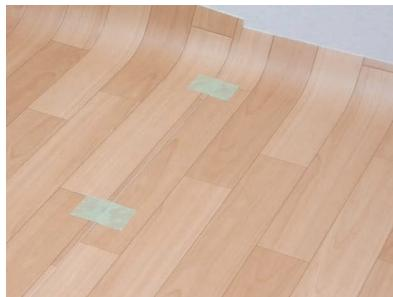
粗切りが終わったら、クッションフロアを重ねた部分がずれないように養生テープで固定し、仮置きしたクッションフロアを半分程度めくります。
