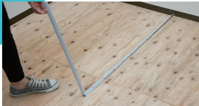
まず床材の必要分量を計算。部屋の見取り図を書き、寸法を測って書き込みます。市販のクッションフロアは90cm幅か180cm幅なので、これを基準にして計画線を入れ、必要量を割り出しましょう。両端にそれぞれ約5cmの余分と柄合わせ分を計算に入れます。
