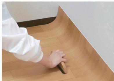
クッションフロアを、空気が入らないようにゆっくりと戻します。なでバケで空気を抜きながら圧着します。雑巾でも代用できます。中央から壁際に向けて空気を抜いていきます。
