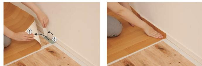
床材を真っすぐ置き、床材①の端を手前にめくり、壁際のテープのはく離紙②を床材1枚分はがします。はく離紙をはがした部分に床材をしっかりと押しつけながら貼ります。
