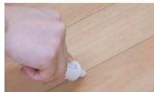
2枚の床材の切れ端を取り除いたら、床に貼ったテープのはく離紙をはがし、すき間や重なる部分がないように床材を貼り付けていきます。3枚目以降も同じ手順。貼り付けた部分にローラーをかけます。仕上げに接着剤で継ぎ目を接着しておきましょう。
