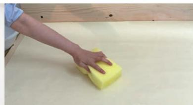
① 1枚目の壁紙を貼る位置に「下げ振り」を下げ、垂直に線を引きます。壁紙の裏にスポンジなどで水をたっぷり付け、のりが戻るまで3~4分そのままおきます。
