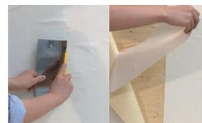
⑥ 壁紙の継ぎ目は、重なっている中央部分に印を付け、定規をあてて2枚同時にカッターで切ります。上に重なった2枚目の壁紙と奥の1枚目の壁紙をはがします。
