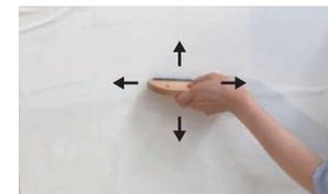
③ 撫で刷毛などを使って、中心から外側に向かって上下左右に撫で、壁紙の中に残った空気を押し出します。
