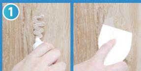
① 下地の凸凹はパテ埋めをします。壁に凸凹や亀裂がある時やベニヤなどのジョイント面は、壁紙貼りの下地用パテを使って表面を平らにしておきます。
