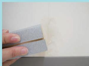
紙製の壁紙をはがれにくい時は、厚めのあて木にサンドペーパーを巻いて、古い壁紙の上からこすり、水分の吸収性を良くします。その上からぬるま湯に中性洗剤を加えたものをスポンジに含ませて、表面を叩くようにぬらしてからはがします。
