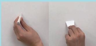
小さな穴の場合は、穴埋め材で穴を埋めます。壁の色に合わせて、穴埋め材を選びます。ヘラで穴埋め材を平らにします。
