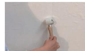
⑦ 継ぎ目部分を左右の壁紙がぴったりと合うようにローラーで押さええます。貼り終えてから空気が入って膨らんでいたら、針を刺して空気を出し、ローラーで押さええます。
