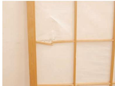
桟が残っている場合は、そのまま木工用接着剤で固定。残っていなければ、折れた部分を糸のこで斜めにカットします。
