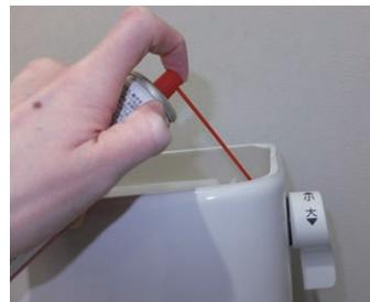
タンクのふたを開け、レバーの心棒部分にノズル付き潤滑油をスプレーするだけでも回転が良くなります。
