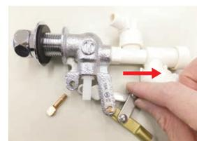
ボールタップの壁側のねじを外して、ピストンバルブを手で取り出します。ねじがとれない場合は、ボールタップごと取り出します。
