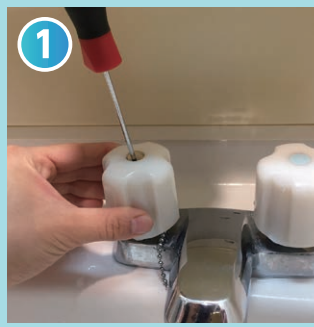
① キャップを外し、ドライバーでハンドルを外します。
