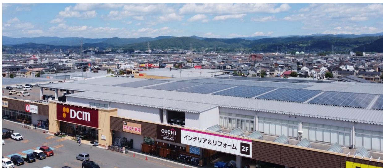
DCM盛南店の太陽光発電設備
