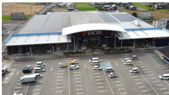
DCM周桑店の太陽光発電設備
